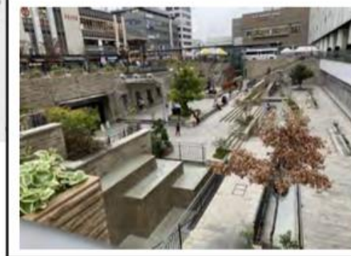
地下広場・駅前広場整備
