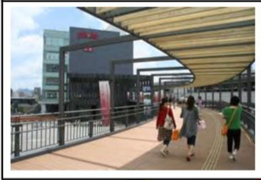
デッキの整備
